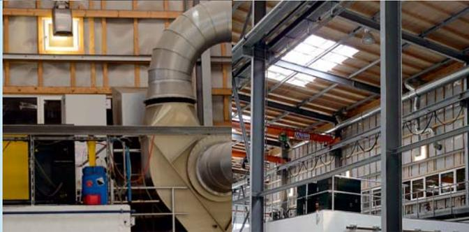
**Maximaler Umweltschutz** - Bei Wiegel befindet sich die gesamte nasschemische Vorbehandlung in einem abgetrennten Bereich (Einhausung). Die Anlage wird von außen bedient. Der Schutz der Mitarbeiter steht im Vordergrund. Innerhalb der Vorbehandlung gibt es keinen Dauerarbeitsplatz.
