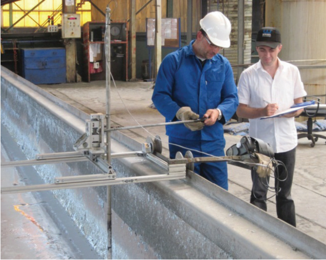
Anwendung innovativer Messtechnologie zur Erhöhung der Lebensdauer von Stahlkesseln im Verzinkungsprozess.
